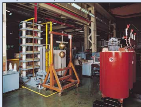
Испытание на устойчивость к импульсным перенапряжениям
