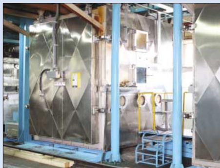
Вакуумная пропитка обмоток
